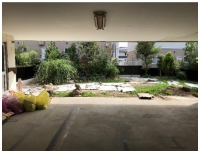
撤去、庭外周フェンス設置
