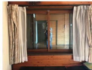
内窓設置 (防音・遮熱効果目的)
