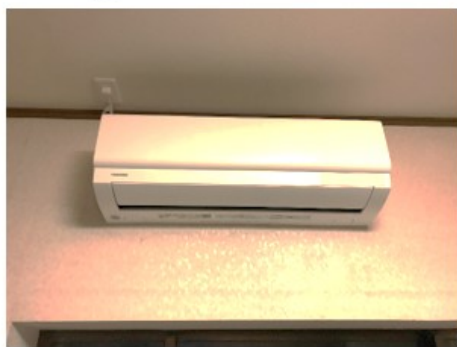
エアコン新設
